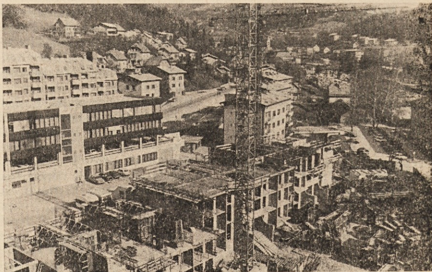
Gradnja novega stanovanjskega bloka na Leninovem trgu v Trbovljah poteka po programu.
