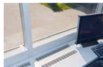
Varnostnik Janko Cimerman je predlagal, da se v vratarnici nad radiatorji na polici namestijo rešetke, ki bodo omogočale boljše kroženje toplega zraka. S tem se preprečijo izgube energije.
