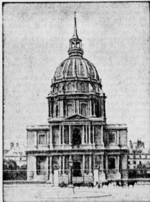
Pogled na »Dom invalidov« od spredaj. Velike kupole požar ni poškodoval.
