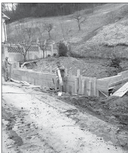
Dela na širitvi ceste in izgradnji podpornega zidu na Prihovi (Fotodokumentacija Občine Nazarje)
