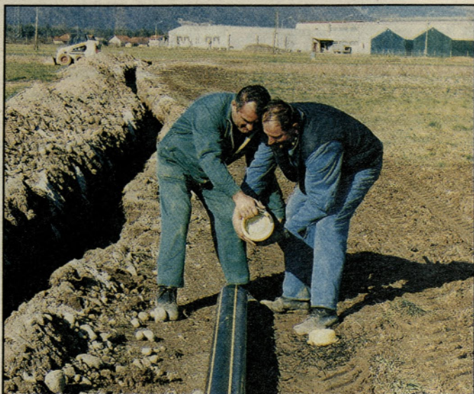
Pri gradnji plinovodnega omrežja na Bregu pri Polzeli
