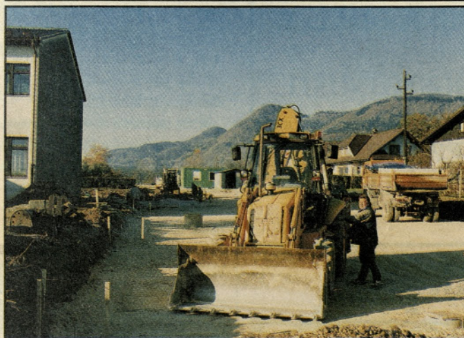
Prva dela, to je izgradnja dovozne ceste in parkirišča za šolo, so se že začela.
