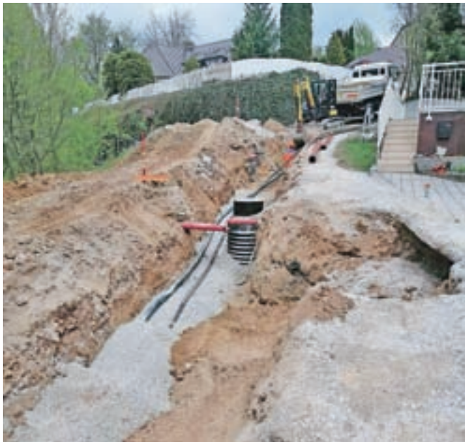
Gradnja kanalizacije na Žalah / FOTO: OBČINA KAMNIK
