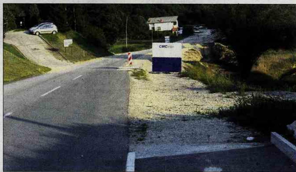
Na koncu Stranja, kjer se konča končani odsek težko pričakovane obnovljene ceste Belo-Pristava pri Mestinju, ki je po novem dvopasovnica. Ob njej je dvopasovna turistična kolesarska steza.
