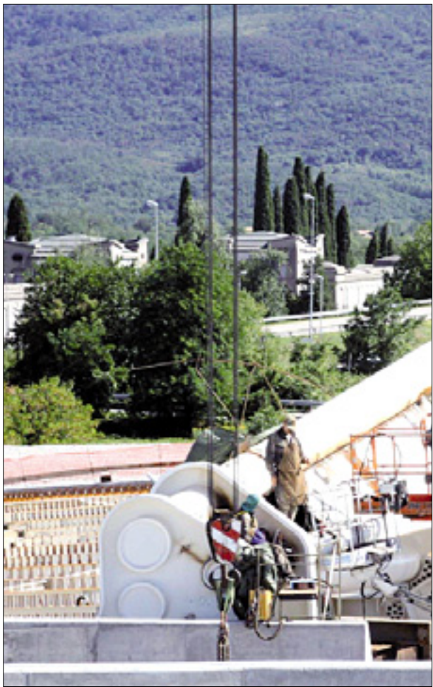
Gradbena dela na loku novega mostu štandreškega krožišča; v ozadju goriško glavno pokopališče
