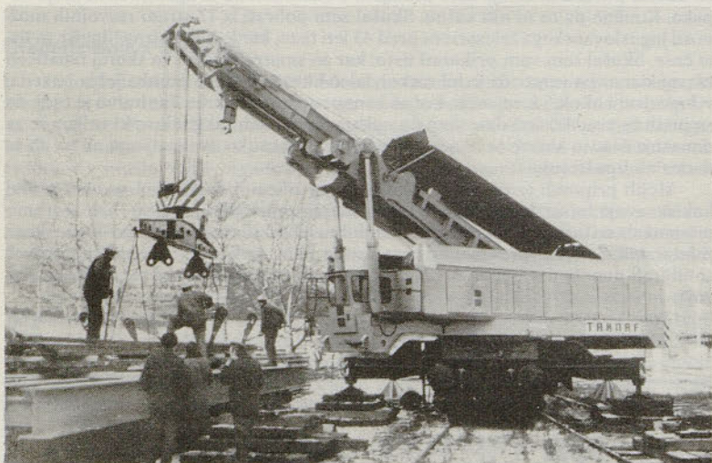
Tirni žerjav ŽTP na testiranju v Štorah. Pri tem so uporabili tudi naše gredice. (foto Arzenšek)
