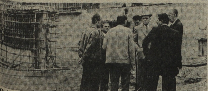
Ogledu stanovanjske gradnje v Fužinah je sledil še ogled gradbišča hidroelektrarne v Mayčičah — Foto: G. B.
