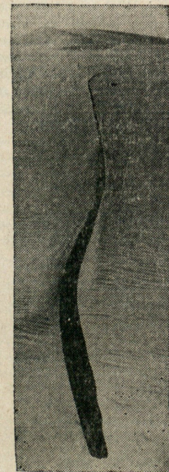
KOT KAČA — Tako se vije cevovod preko peščene puščave v Libiji od petrolejskega polja do pristanišča obali Sredozemskega morja.
