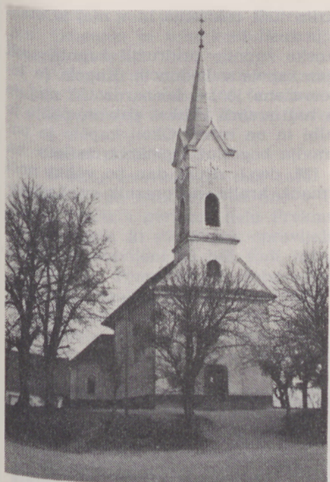
Obnovljena cerkev v Pečarovcih
