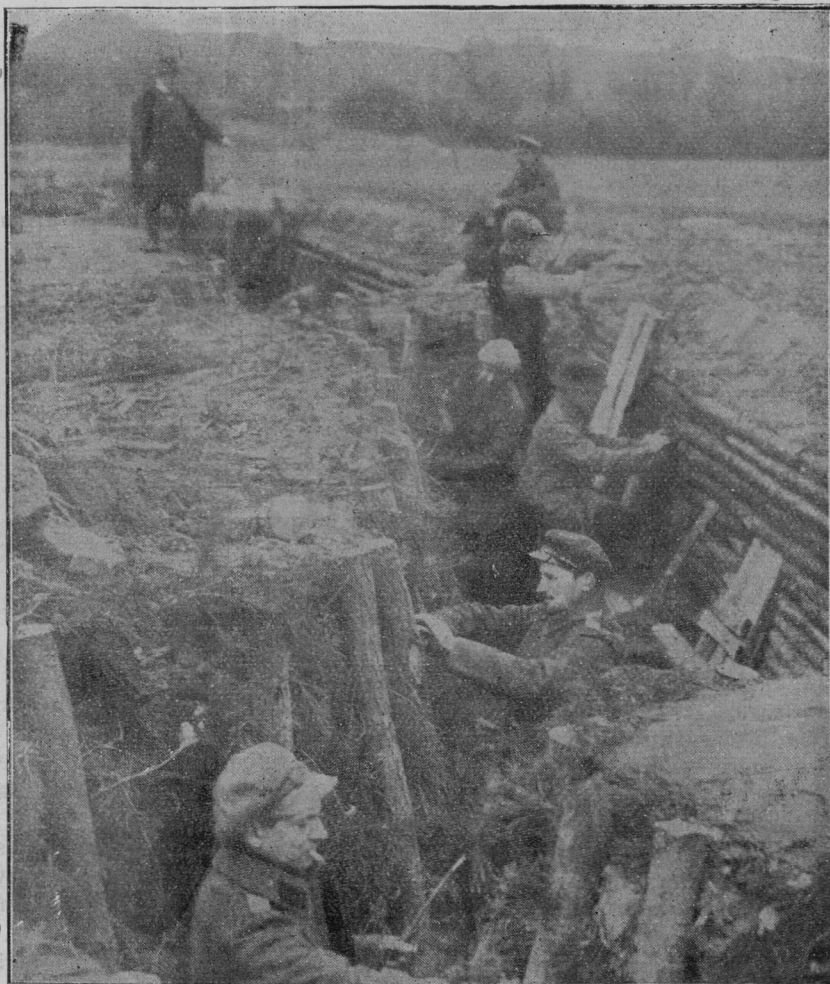
Za bojno črto na francoskem bojišču delajo črnovojniki nove strelske jake, ki jih z betonom in lesom utrjujejo.
