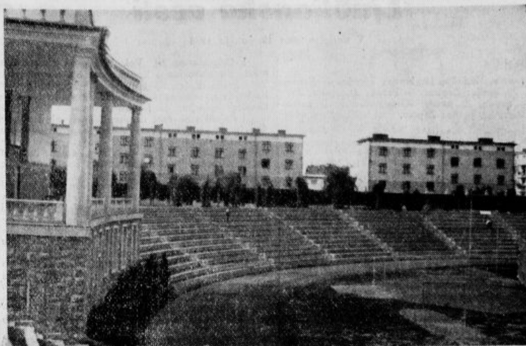
Novozgrajeni betonski sedeži na Stadionu.
