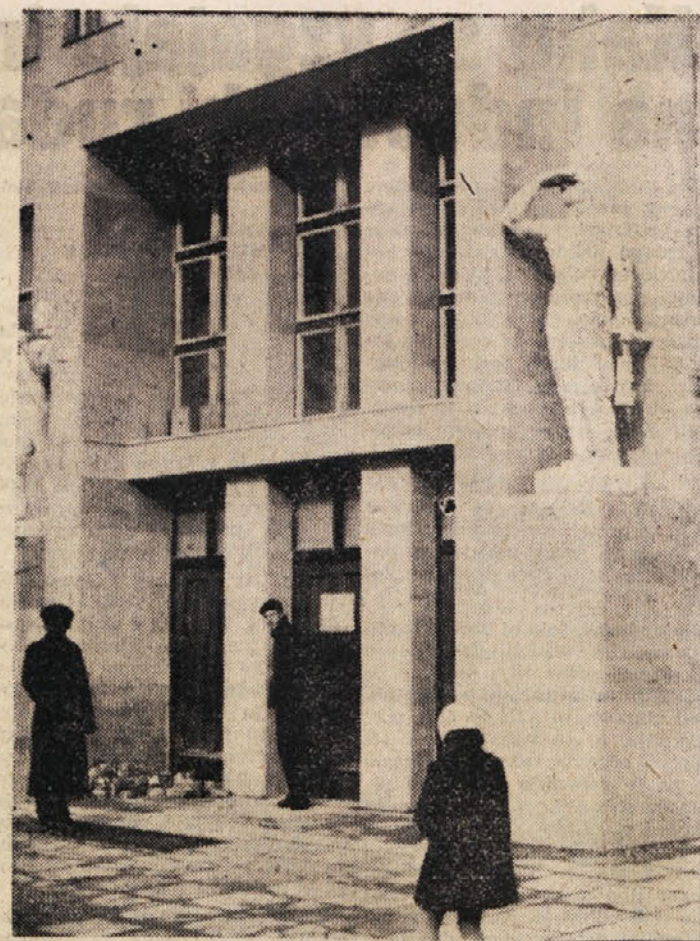
Vhod v poslopje sedeža trboveljske občine je dobil novo podobo. Na novo sta bila prepleksana tudi oba, Kalinova »Rudarja«.
