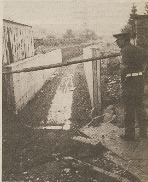
Pogled na že obnovljeno in zavarovano strugo (Foto Marinčič)
