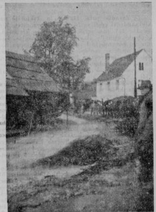
Na levi porušeni hlev delavca Stefiča. — Sredaj razdrta in poplavljen banovinska cesta. Zada je množica ljudi opazuje razdejanje.
