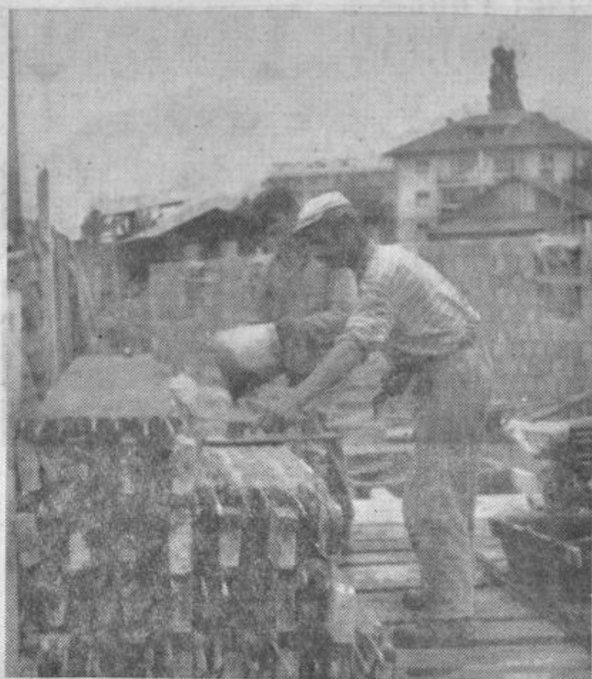
Gradbeno podjetje »Vegrad« letos pospešeno gradi družinska stanovanja za prodajo. Na prostoru med železnico in novim Velenjem gradijo kar tri 17-torčke. Na sliki delavca, ki delata stebre za betonske plošče.
