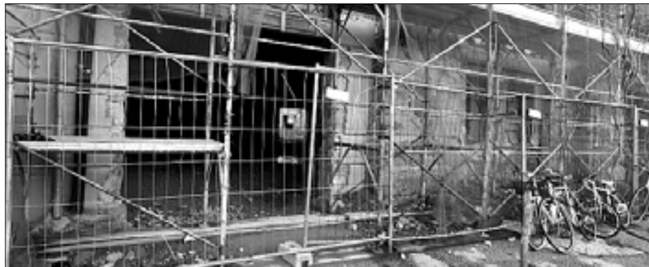
Včeraj so delavci postavili dolgo napovedano ograjo pred vhode v silos
