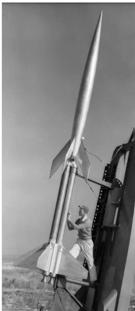
Tehnik PARD-a Durwood Dereng meri elevacijski kot pred lansiranjem raziskovalnega modela RM-10 z dvema buster motorjema deacon na preizkusnem poligonu Wallops v Virginiji 6. februarja 1951.
