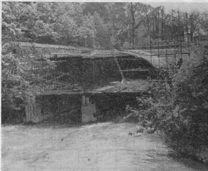
Dela pri gradnji mostu za novo cesto lepo napredujejo
