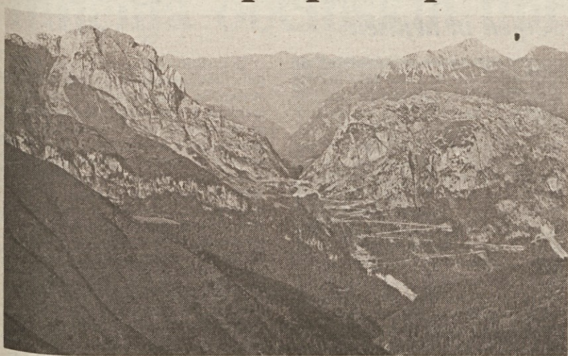
Mejni prehod na Pločah, kjer nameravajo zgraditi cestni predor
