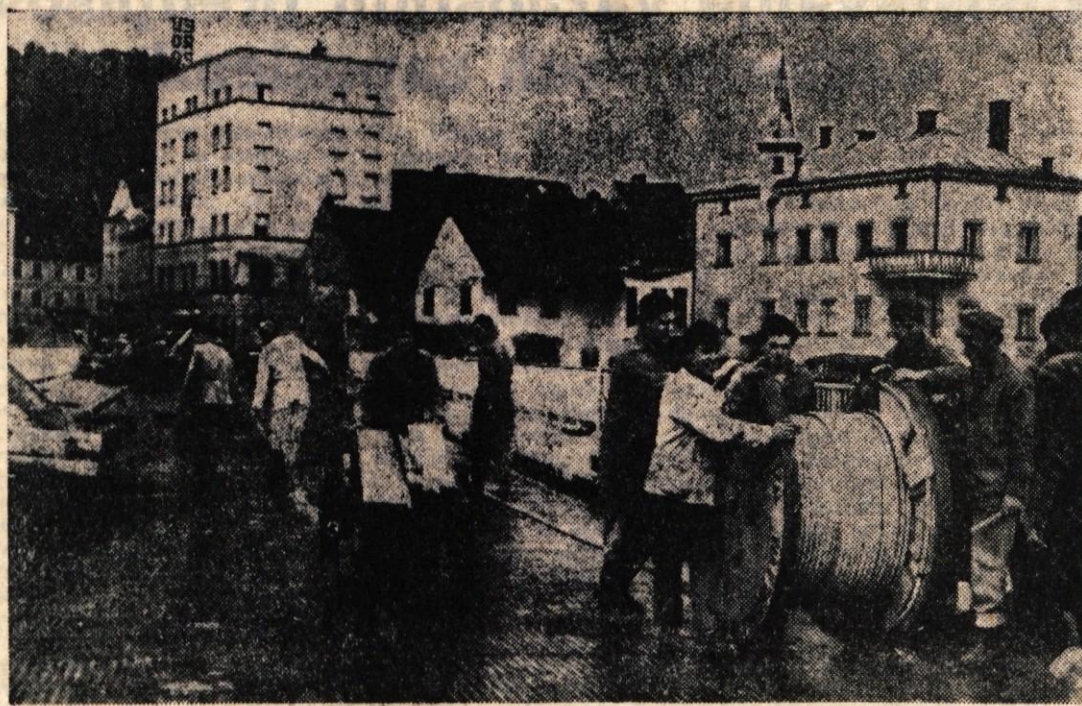
Se dva tedna in most čez Kokro v Kranju bo izročen namenu. To bo za 29. november. Zdaj se urejajo dostope na most na obeh bregovih Kokre in čistijo mostno ploščad
