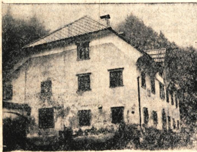
Nekdanja gostilna in pošta »Pri Čošeljnu« v Podkorenu
