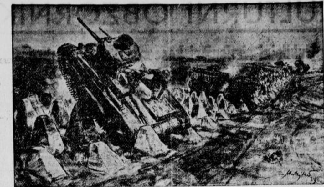
Učinek po novem utrjene meje: Tank je običal na betonskih zobeh, ki širilo iz zemlje. Taki zobje so v širokem posajeni po mnogih mejah zahodnih držav in jim je glavni namen: ustaviti tanke.
