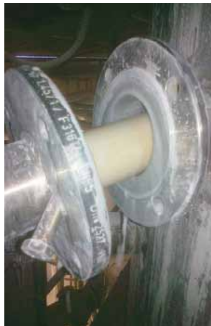
Montaža merilne sonde
