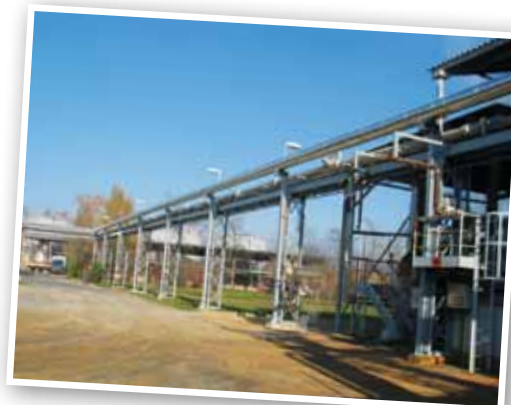
Pogled na rekonstruiran energetski most s parovodom med skladiščem žvepla in »S«-kislino
