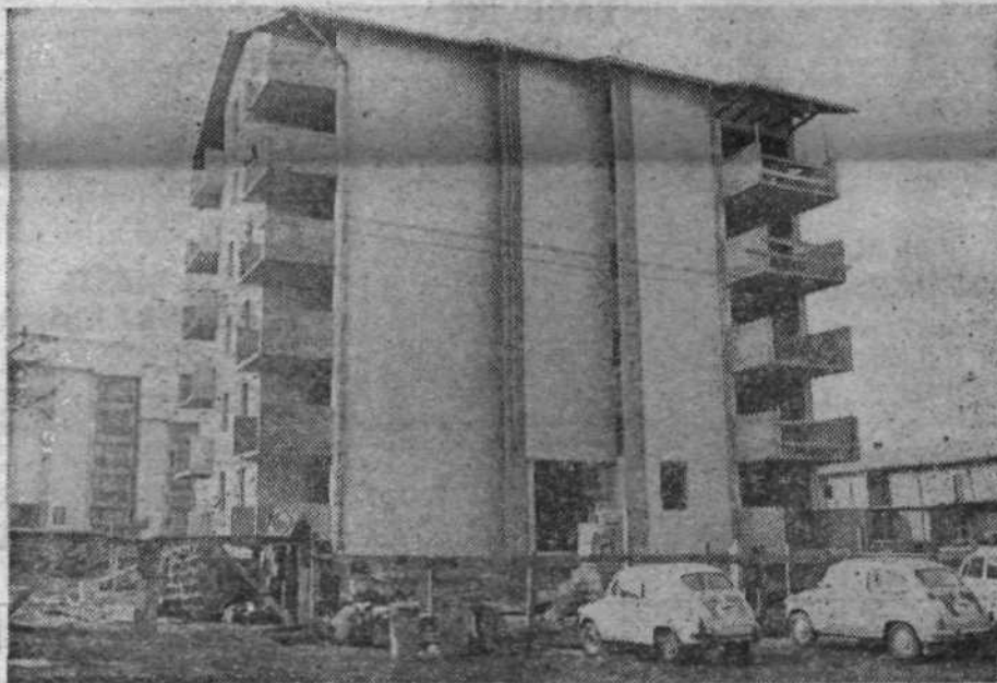
Gradnja stanovanjskih stolpičev, blizu tovarne Elma na Črnučah. Investitor je stanovanjsko podjetje Fond.
