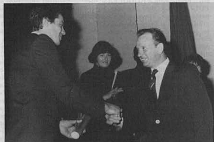
Rudolfu Poljanšku za organizacijo dela in veliko požrtvovalnost pri izgradnji vodovoda v Goropekah
