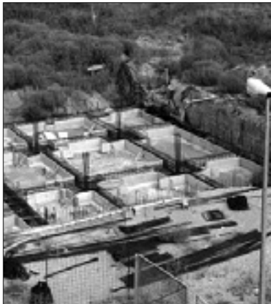
Gradbišče VDC na Sedejevi ulici K.M.
