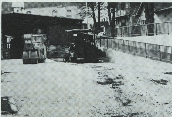
Finišer polaga zadnje metre asfaltne prevleke ob skladiščnih objektih
