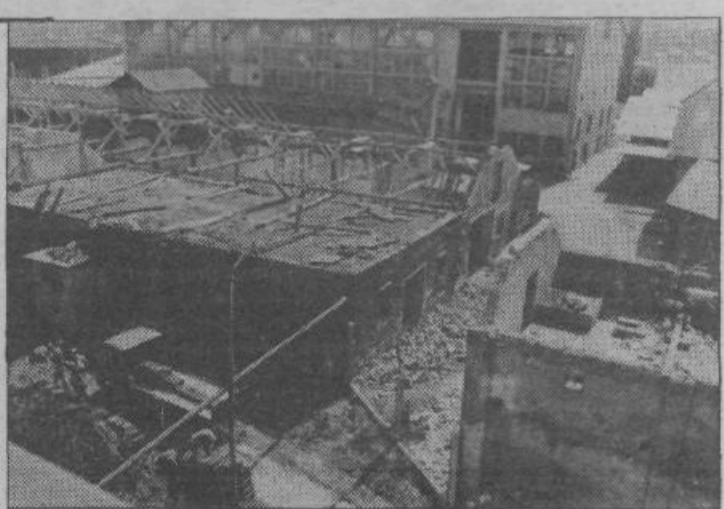
Takole je bilo treba najprej porušiti in odstraniti nekdanje Keminove zgradbe, nakar so začeli z izkopom (foto: J. Praprotnik)
