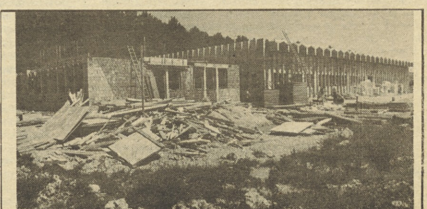
Gradnja nove tovarne Industrijske elektronike v Kostanjevici zelo dobro napreduje. Na gradbišču so nam rekli, da bo najbrž gotova še pred pogodbenim rokom: za dan republike — 29. novembra.
