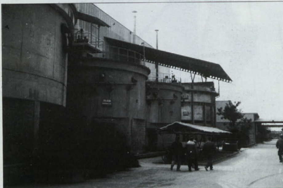
Ob dveh obstoječih, je postavljen še dvojni tretji in četrti usedalnik.
