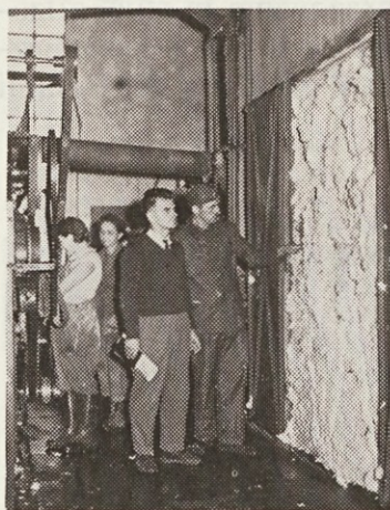
V mešalnih celicah smo imeli v preteklosti veliko požarov. Pred gašenjem smo morali odkriti žarišče požara.
