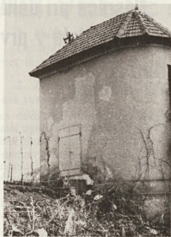
Savska črpalka ob Savi po dolgoletnem delovanju še vedno črpa porabno vodo za požarni bazen.
