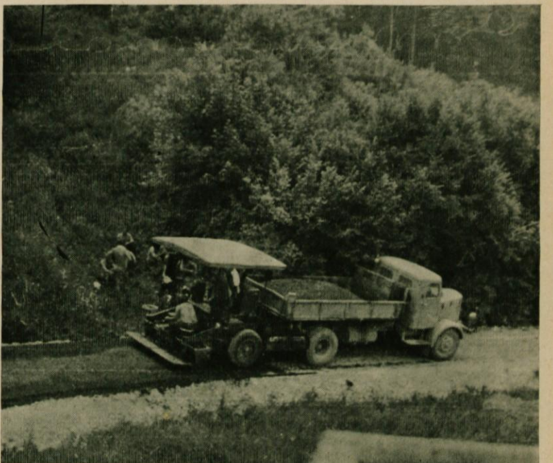
Asfaltiranje ceste na KRUMPERK
