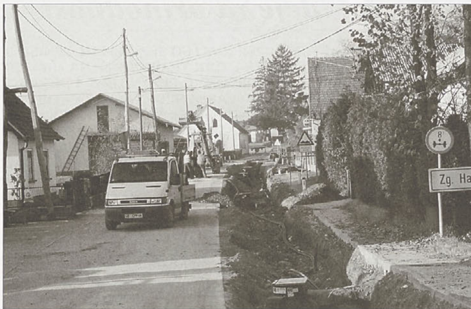
Kanalizacija zdaj tudi že na Zg. Hajdini. Foto: Občinska uprava
