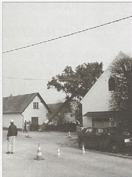
Letos jeseni so jo morali žal podreti, umakniti pa se je morala ob urejanju kanalizacijskega omrežja in prometne ureditve na Zg. Hajdini.
