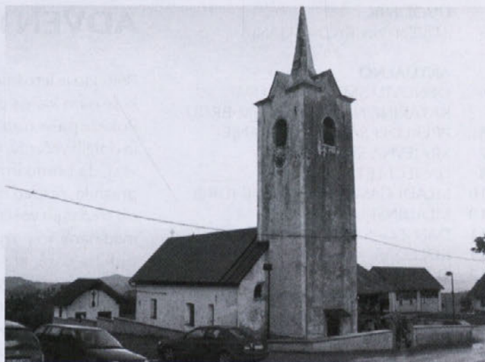
Cerkev pred obnovo.
