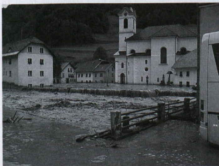
Poplavljeni Železniki. Vir: www.PhotoVillage.org
