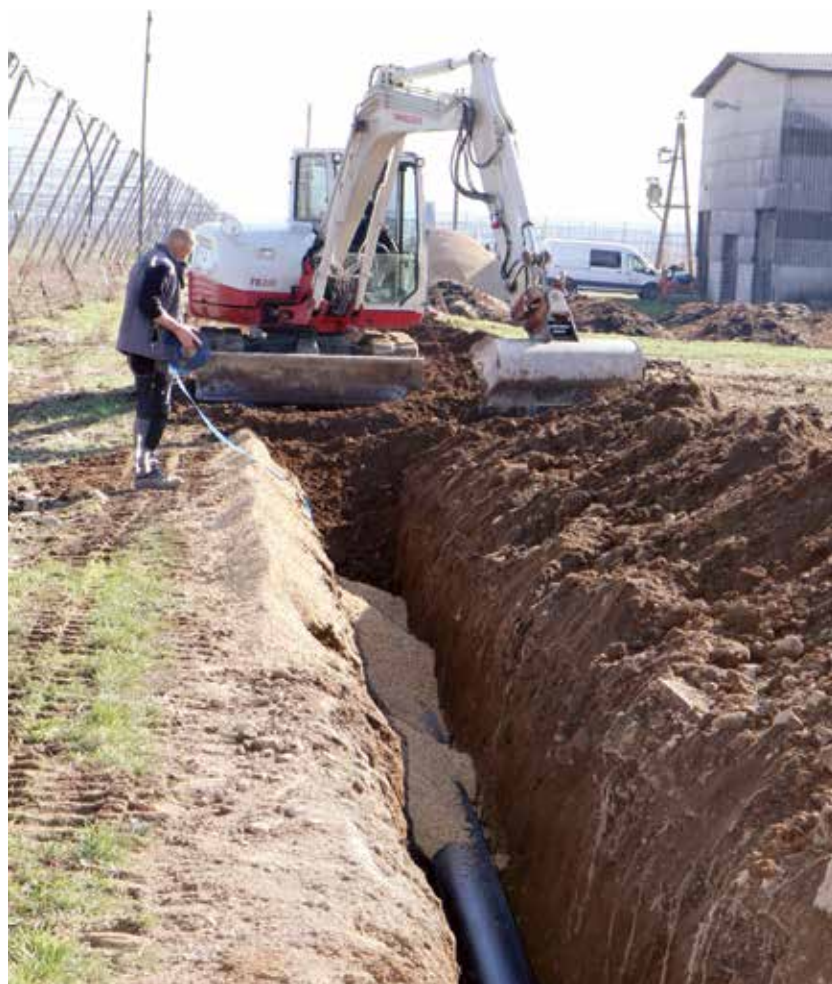
Pri obnovitvi namakalnega sistema Breg-Roje
