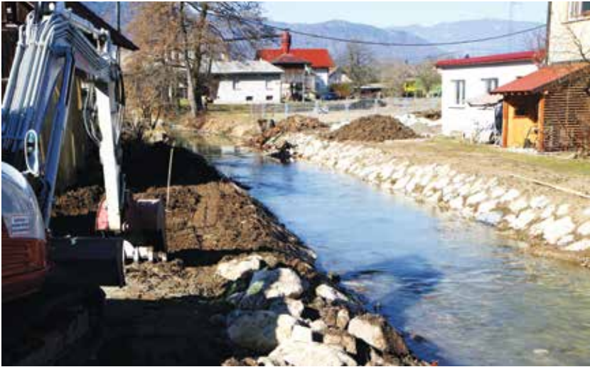
Vzdrževalna dela na Podvinsko-žalski Strugii na Polzeli
