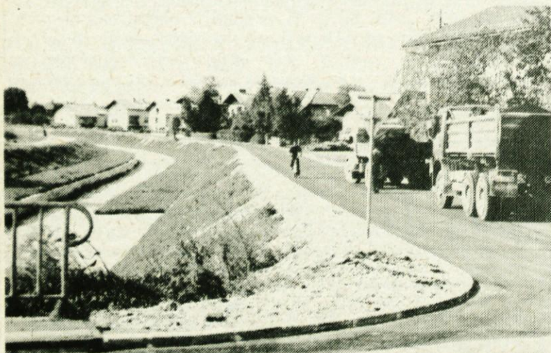
Nov asfalt na Veselevem nabrežju v Mengšu je pomembna krajevna obogatitev (foto Janko Skok)
