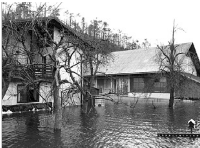
Na območju Planine in Laz je vse več hiš pod vodo
