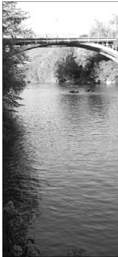
Soča pri pevskega mostu BUMBACA
