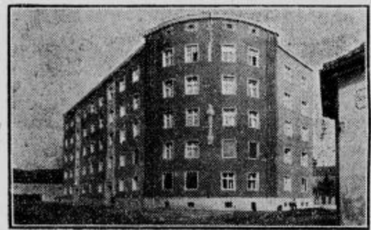
Monumentalna oblastna stanovanjska palača v Strossmajerjevi ulici. (Gradili stavbni podjetji Nassimbeni in Kiffmann.)
