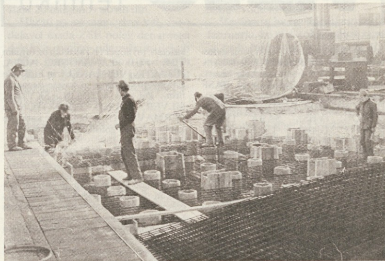
V tozdu OB delavci pripravljajo temelje, na katere bomo prestavili pomolno vrtnalno stroje KOLB. Na mesto, kjer so bili doslej, pa bomo postavili nov vodoravno vrtnalni rezkalni stroj. Na tem stroju bomo obdelovali tako velike obdelovance kot jih sedaj obdelujemo že na obstoječih strojih FRORIEP in SIBIREC, ki sta na 14. polju. Novi stroj bo imel vgrajeno tudi vrtiljivo mizo. (Foto: E. L.)
