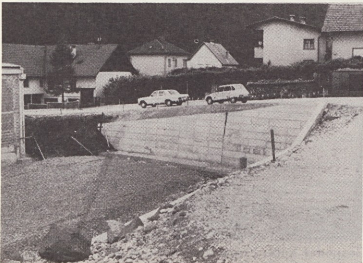
Nova cesta poteka okoli skladišča in Bajerja
