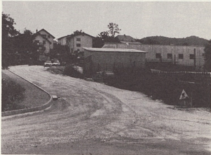
Priključek nove ceste na spodnjo Topilniško cesto
