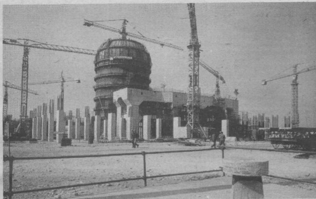
Po vrsti hidro in termo elektrarn je Gradis prevzel tudi gradnjo prve jugoslovanske jedrske elektrarne v Krškem
