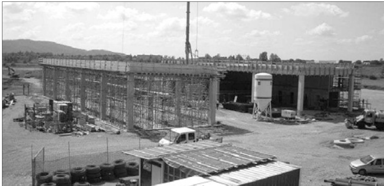
Gradbišče v Vrtojbi
