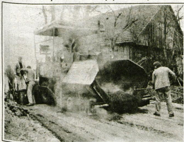
Takole se je sredi novembra pokadilo za gradbenimi stroji, ki so na cesti med Lužami in Srednjo vasjo polagali asfaltno prevleko.
