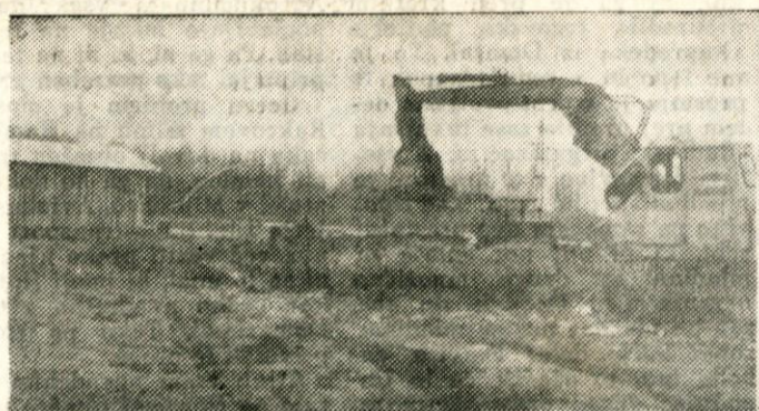
Dela na gradbišču za novi transformator so v polnem teku. To pa je posledica »športa« posebne vrste. Zgodilo se je v Domžalah pred avtobusno postajo. Bilanca: nekateri imajo srečo!
