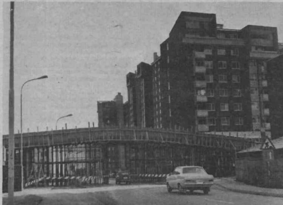
NADHOD ZA PEŠCE – V Soseski 7 gradijo nadhod nad Ulico 7. septembra, ki bo povezoval Glinškovo ploščad in zahodni del Bratovševske ploščadi. Objekt je seveda že dobil ime: pravijo, da je to »most vzdihlajev«.
