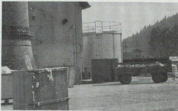
Okoli dimnika je bilo odstranjeno odpadlo železo in tekstilni odpadki. V delovni organizaciji je opaziti večjo skrb za varstvo okolja.
