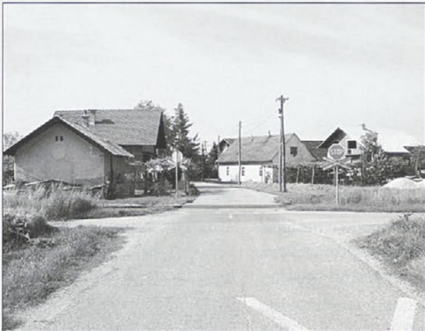
Nujno je potrebno urediti železniški prehod. Foto: RŠ.
