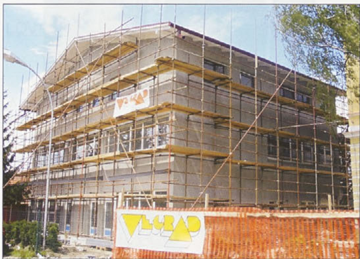
Zaključna dela na vrtcu in knjižnici.
